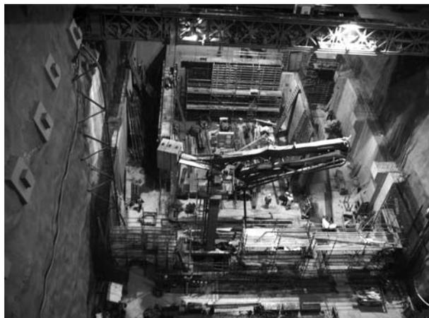
Abb. 2 Maschinenkaverne: Betonverteiler
