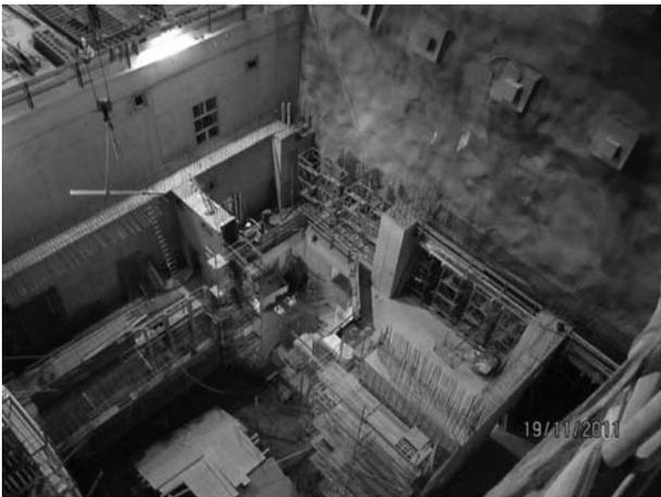
Abb. 4 Maschinenkaverne: Betonage des Maschinenblocks
