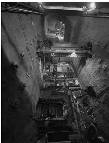
Abb. 3 Betonarbeiten in der Maschinenkaverne
