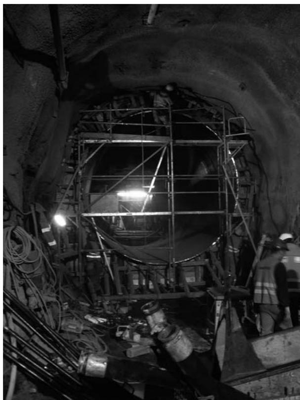
Abb. 7 Oberwasserstollen: Hinterfüllen der Panzerung
