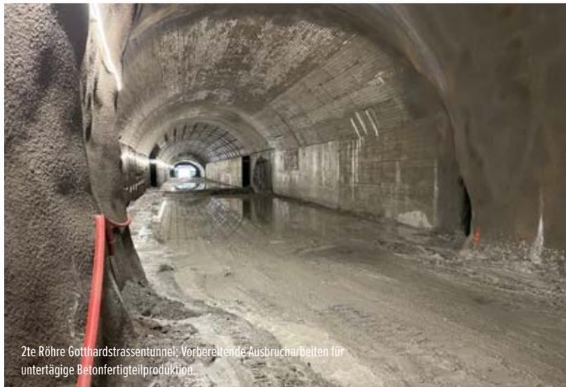
2te Röhre Gotthardstrassentunnel: Vorbereitende Ausbrucharbeiten für untertägige Betonfertigteilproduktion
