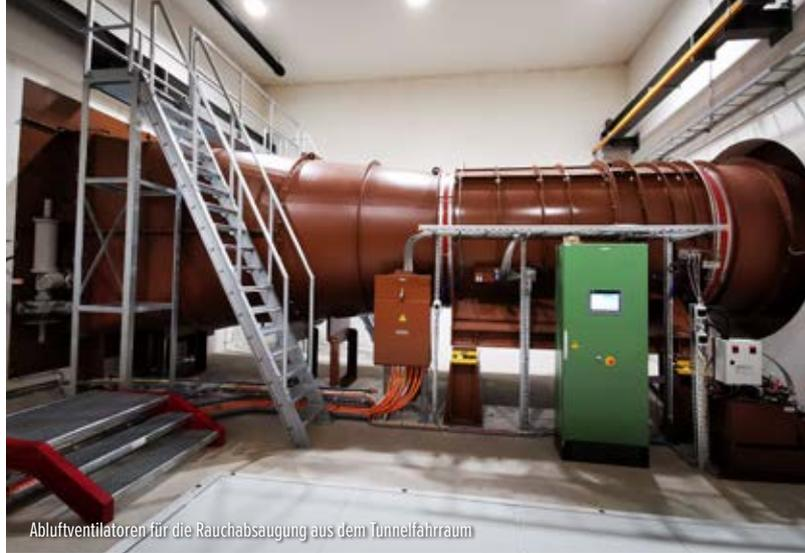
Abblüventilatoren für die Rauchabsaugung aus dem Tunnelraum
