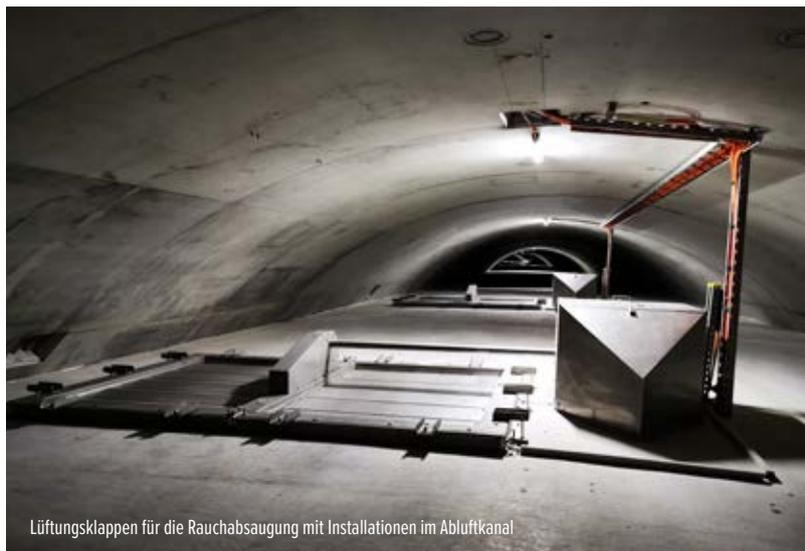
Lüftungskappen für die Rauchabsaugung mit Installationen im Abluftkanal
