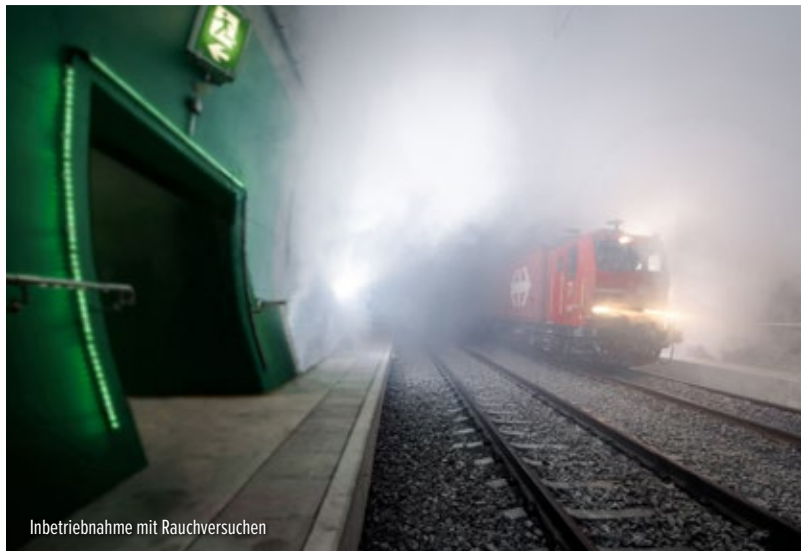
Notausgang mit Schiebetür und Fluchtwegsbeleuchtung
