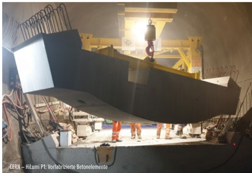
PSW Limmern: Ein-/ Auslaufbauwerk Mutsee
