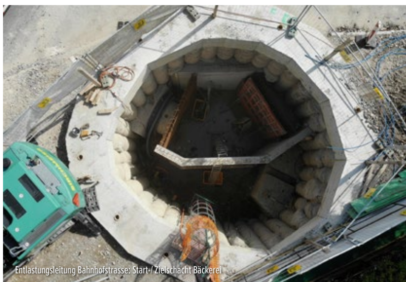
Entwässerung Fahrweid: Durchstich Haltung Nord 2 mit AVN800
