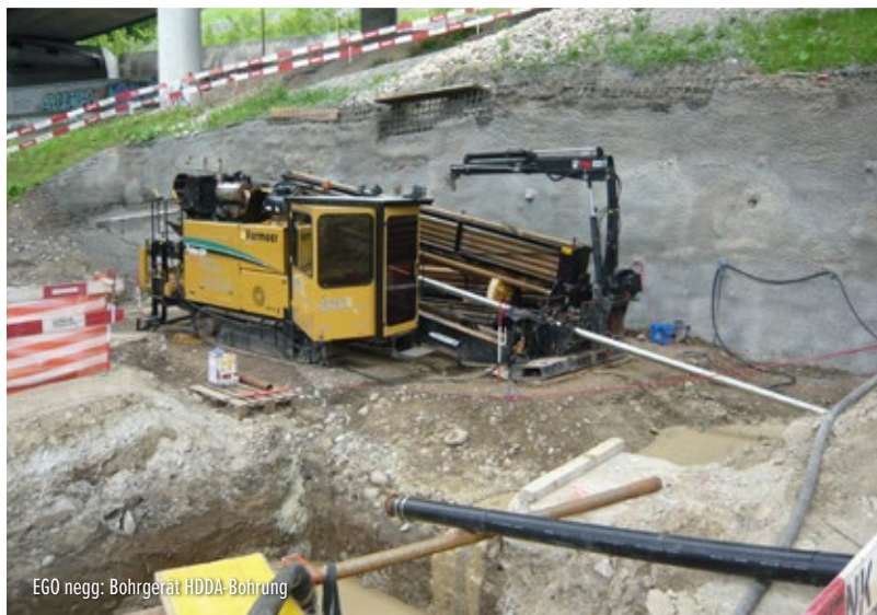
Zulaufkanal RB Schützenwiese: Pressenanlage Startschacht
