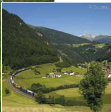
Sanierung Brenner Eisenbahn, Österreich
