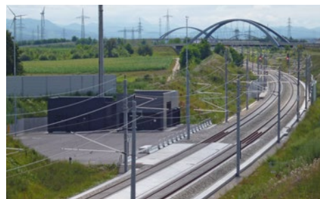
Neubaustrecke Wien–St. Pölten, AUT
