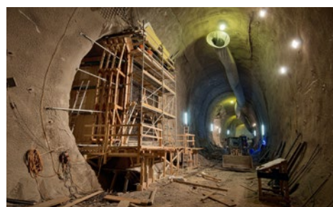
Tunnelzuführung Hauptbahnhof – Stuttgart 21, GER
