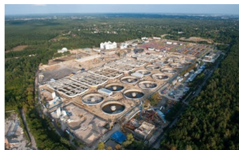
Abwasserreinigungsanlage Czajka, POL
