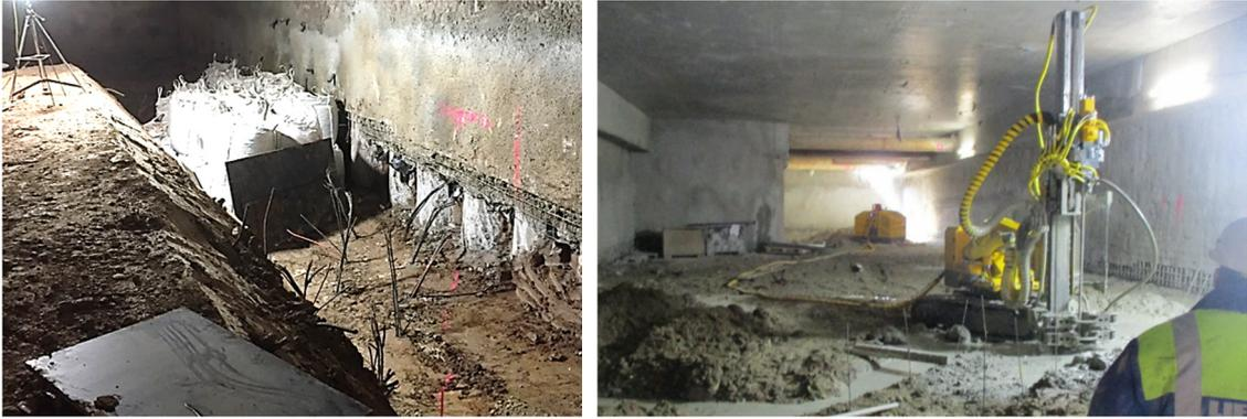
Abb. 16: Notfallmaßnahme „Big Bags“ (links); geringe Arbeitshöhe bei Mikropfahlherstellung (rechts)
