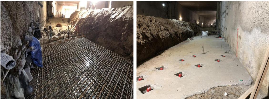
Abb. 17: Bewehrte Zwischensohle vor dem Betonieren (links) bzw. nach Aufbringen der Vorspannkraft (rechts)
