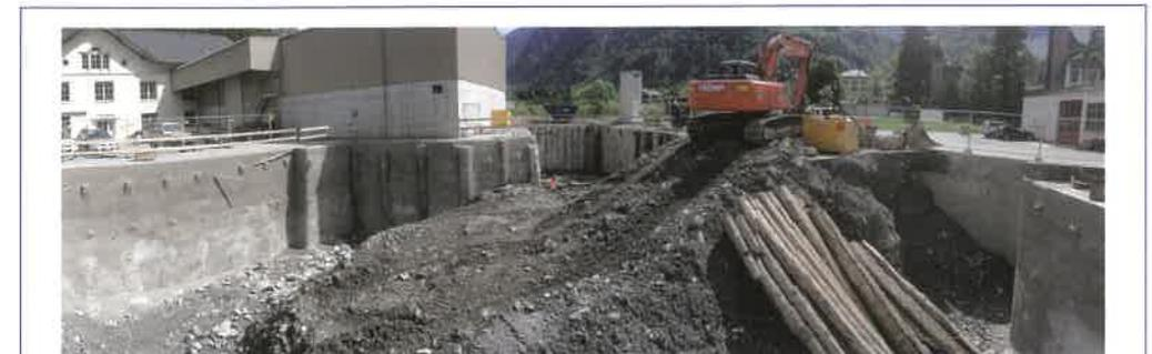
Abb. 6: Baugruben der Wasserschlosskammer und im Hintergrund jene des Einlaufbauwerkes während des Aushubes
