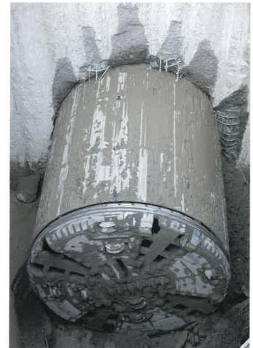
Abb. 9: Durchschlag der Tunnelbohrmaschine am 13. September 2016 in die Baugrube des Einlaufbauwerkes
