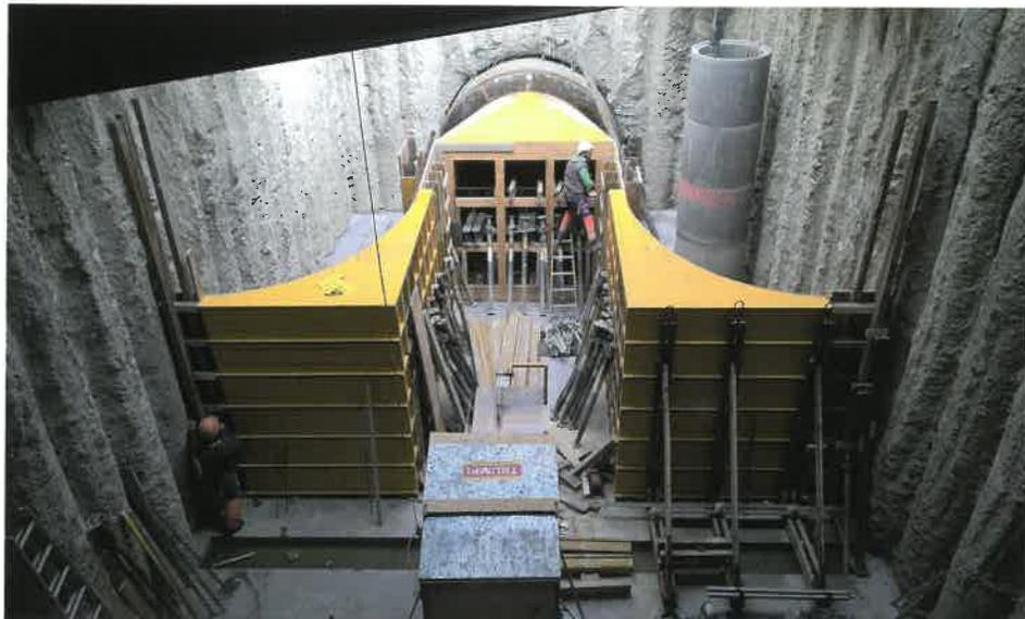
Abb. 7: Schalung des Einlauftrichters mit Anschluss an das Rohr des Oberwasserkanales im Hintergrund
