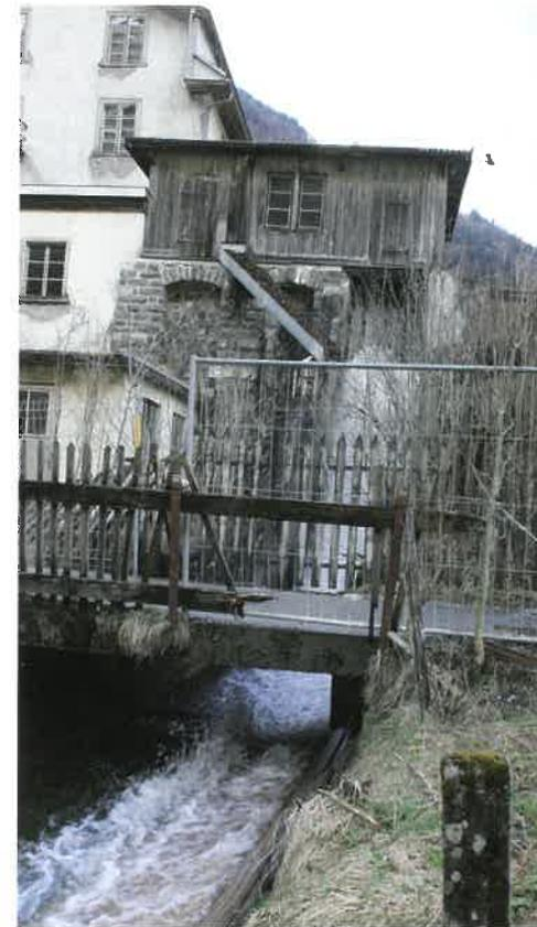
Abb. 2: Altes Krafthaus (seitlich gesehen) mit Entlastung aus dem Oberwasserkanal in Richtung Linth. Rechts oben fließt der Oberwasserkanal zu, der Unterwasserkanal liegt hier unterirdisch und verlässt das Krafthaus linksseitig (in Richtung Norden).
