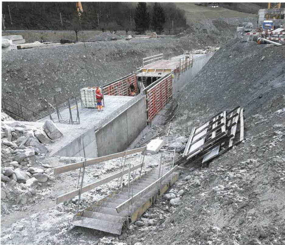
Abb. 12: Schließen des Oberwasserkanales nach der Fertigstellung des Rohrvortriebes
