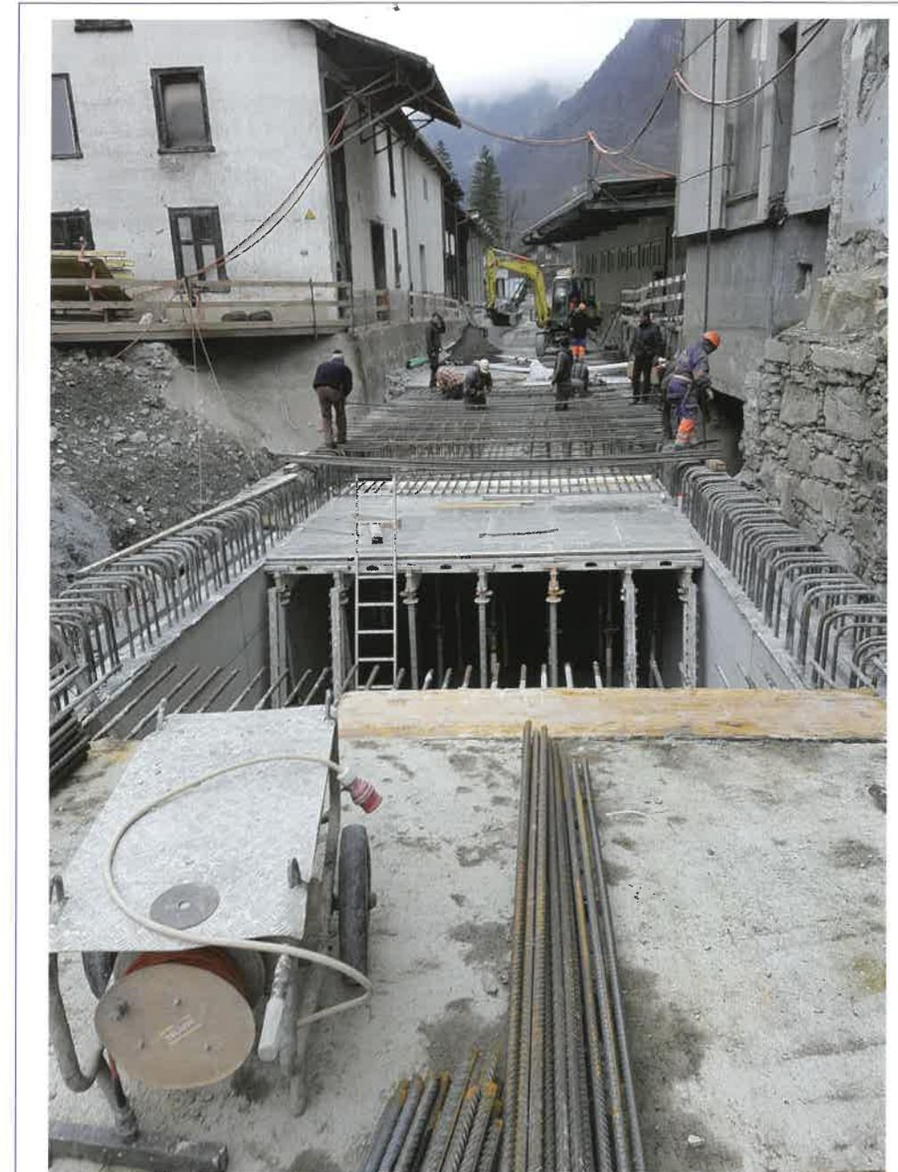
Abb. 11: Oberwasserkanal bei der Durchfahrung des Cotlan-Areals mit beengten Verhältnissen – eine Aufnahme aus dem Bereich des alten Krafthauses
