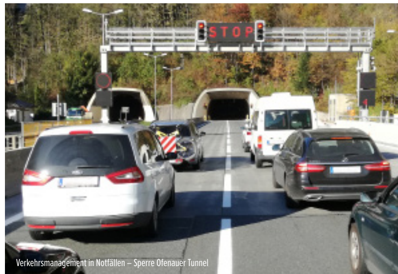
Randweg- und Ringbeleuchtung – Wienerwaldtunnel © ÖBB
