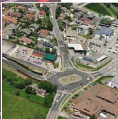
SS12 Umfahrung Vahrn, Italien
