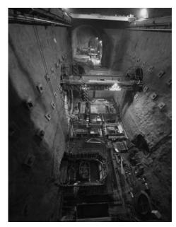
Abb. 3 Betonarbeiten in der Maschinenkaverne
