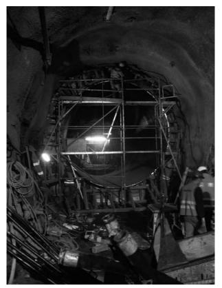
Abb. 7 Oberwasserstollen: Hinterfüllen der Panzerung
