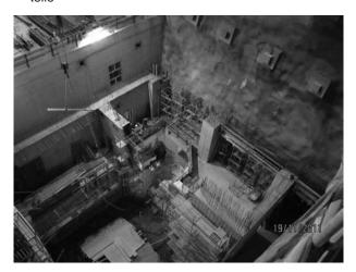
Abb. 4 Maschinenkaverne: Betonage des Maschinenblocks
