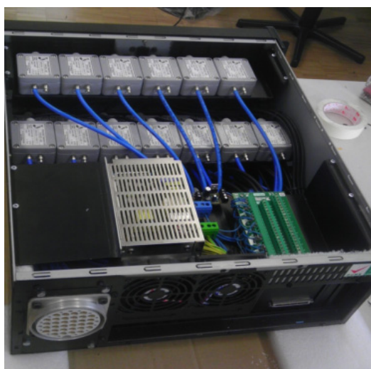
Abbildung 11: Bild des Druckmesskoffers (einer von zwei Racks) samt Elektronik
