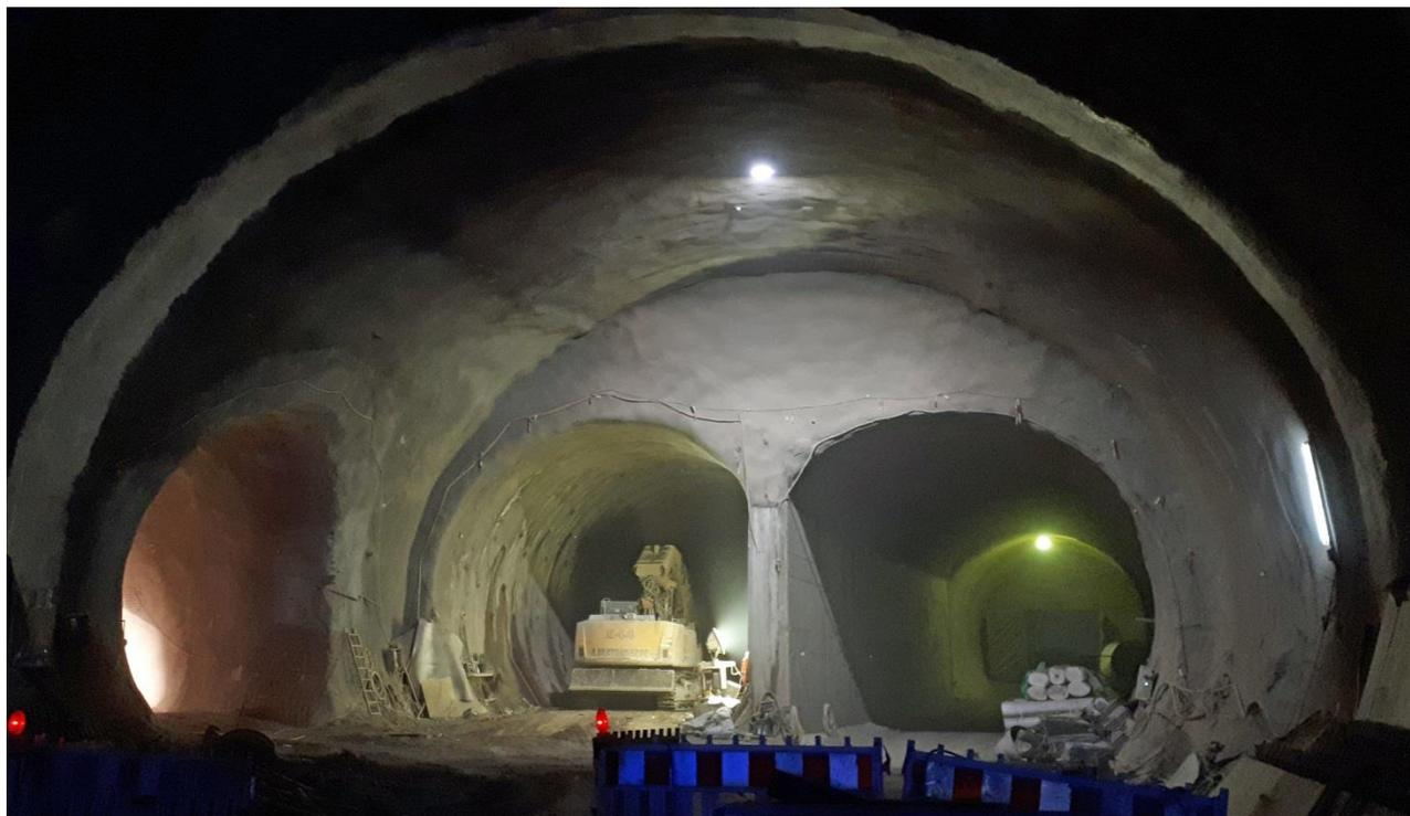
Abbildung 9: Kreuzungsbereich A177 mit dem Vbw 1.5.2.7 nach Fertigstellung des Vortriebes mit Ortbetonmittelpfeiler
