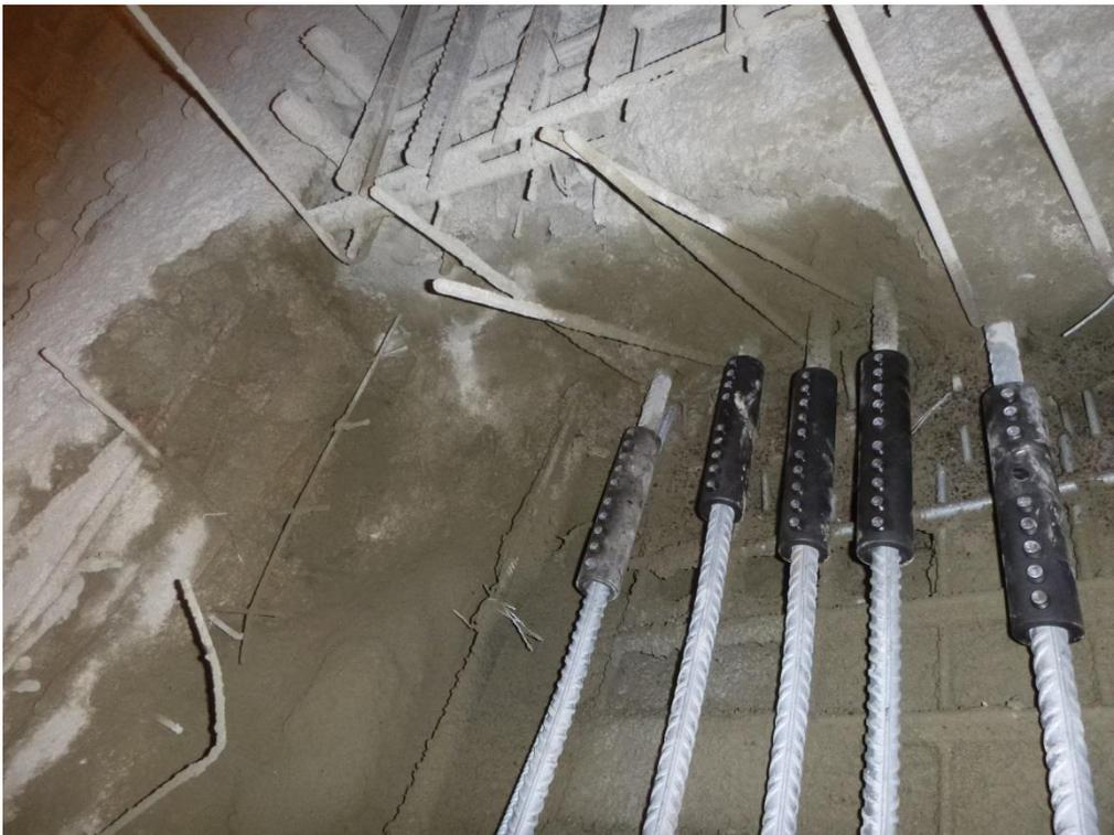
Abbildung 5: Einbau Muffen und lagenweiser Einbau Spritzbeton am Übergang Kalotte/Strosse
