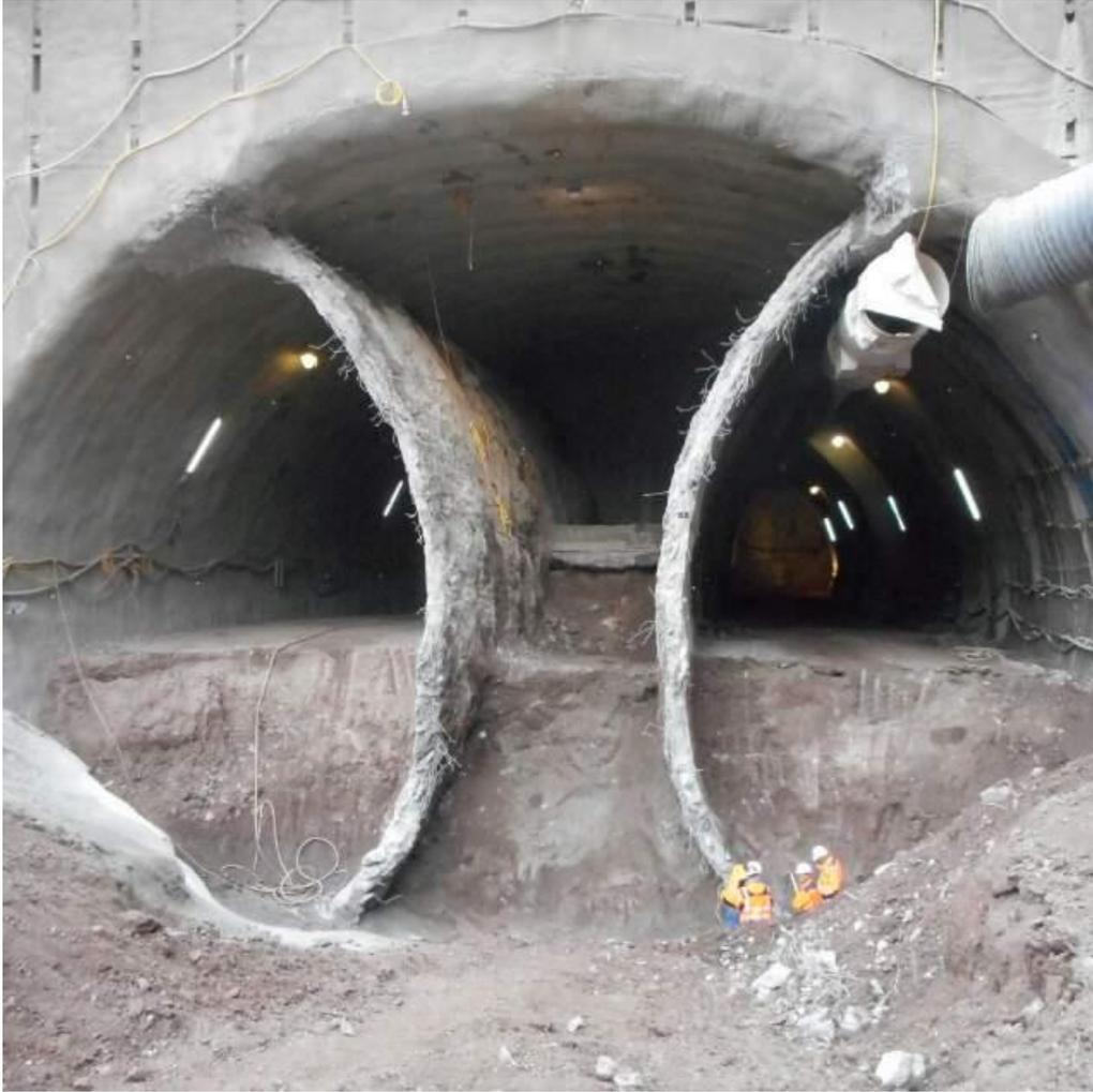
Abbildung 4: Umenstollen- und Kernvortrieb 2-gleisiger Querschnitt im Bereich des Verzweigungsbauwerkes Kriegsberg
