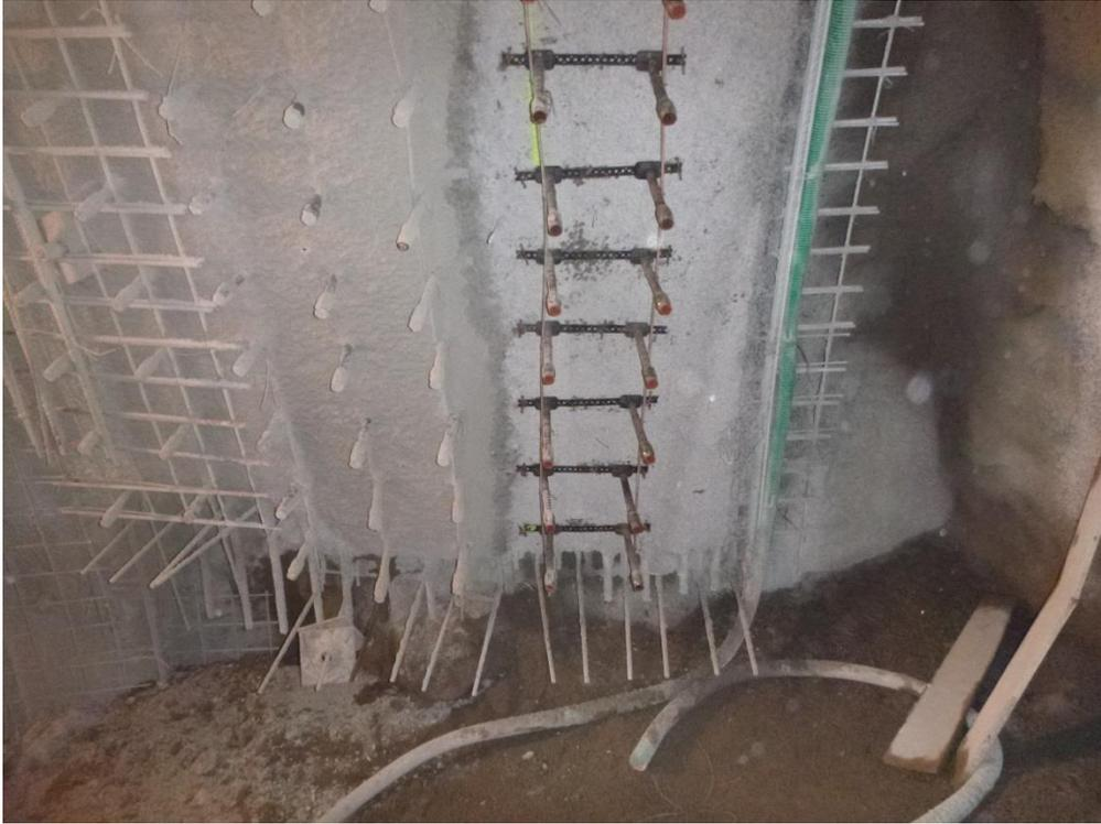
Abbildung 7: Einbau Schubdübel (Phase 1) im Anschlagbereich VBW 1.5.2.7 der Achse A177
