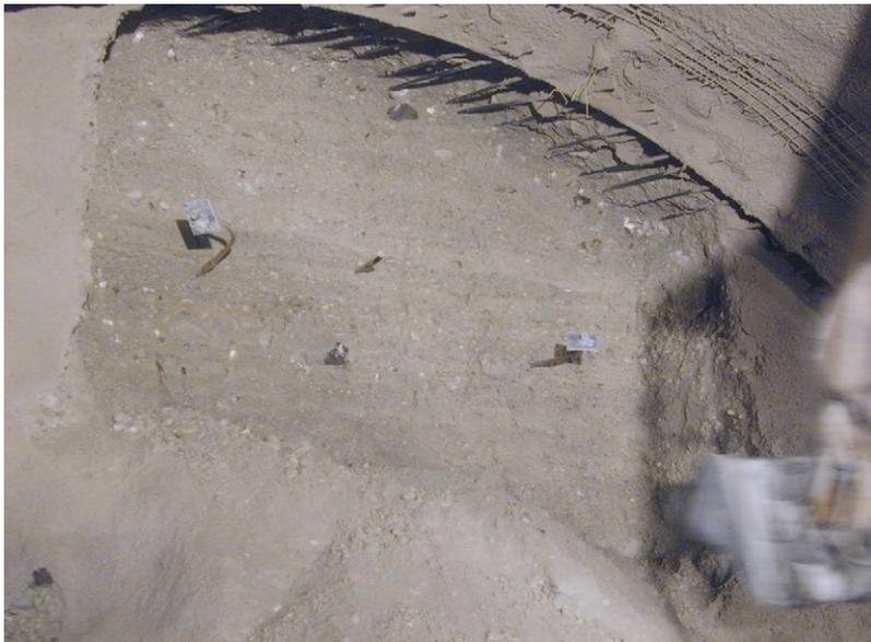
**Bild 6** Vortrieb H5W, Kalotte bei TM 1 025,6. Lagig aufgebaute Vorterrassenschotter. Voraussicherung mittels Rammspießen.
