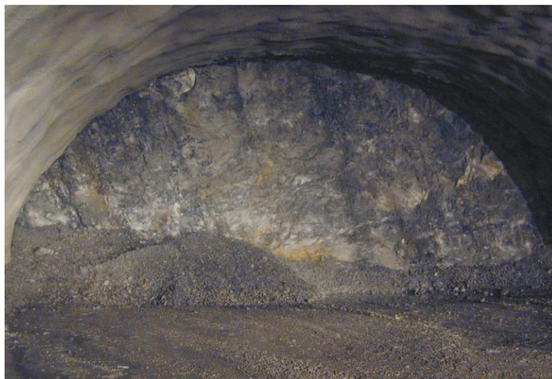
**Bild 5** Vortrieb Vomp Ost, Kalotte bei TM 2 847,2. Hauptdolomit. Bogenfreier Ausbau des dreigleisigen Querschnitts bei Abschlagslängen bis zu 2,2 m.
